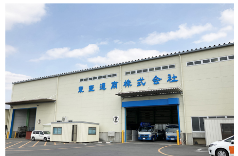
東亜通商は2年前の河川氾濫で被害を受け、建屋を改修した
